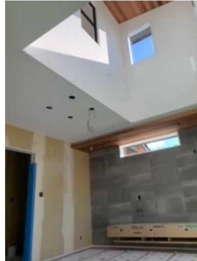
画像は施工中を使用
